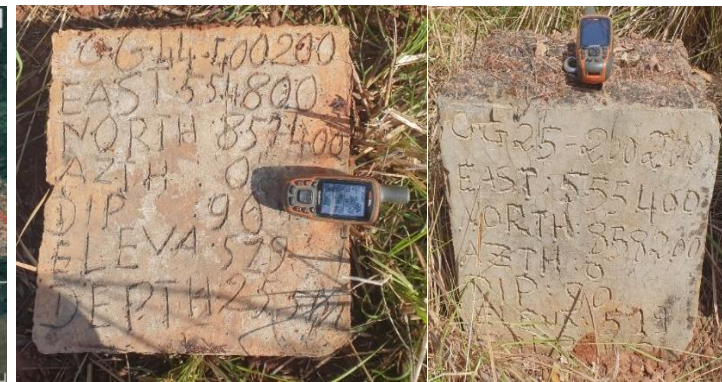
Photo 5 : Les bornes des forages identifiés sur le site.
